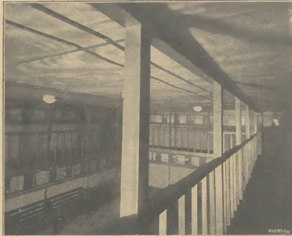
Abb. 31: Außenansicht der Übungstrecke von der Beobachtungsgalerie aus
