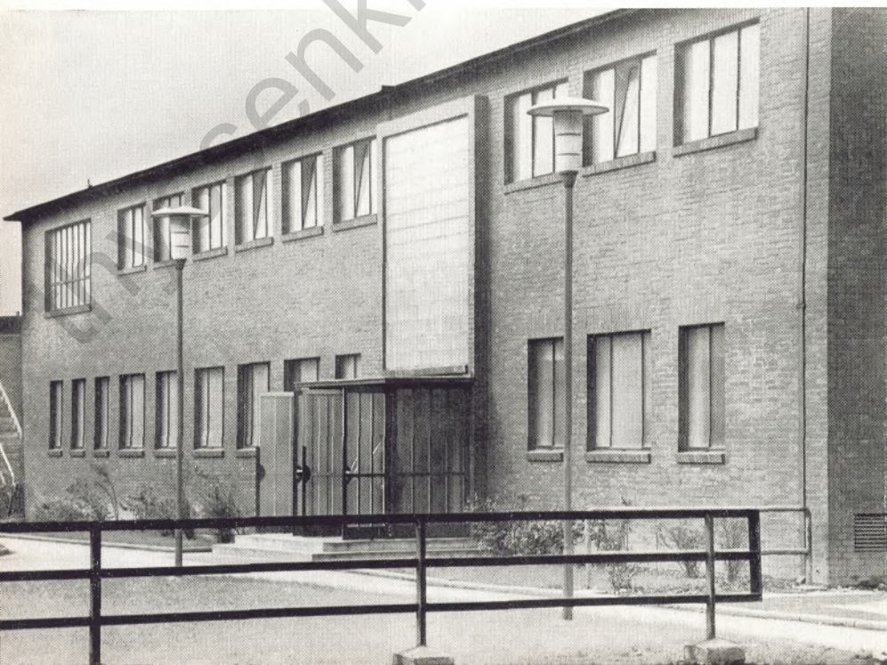
Belegschaftshaus I in der Nähe des „Bundeshauses“ wird aufgestockt und erweitert
