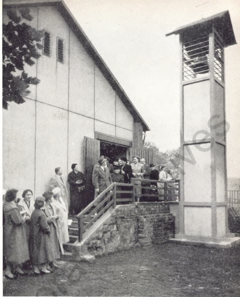
Stolz erhebt sich der neue Glockenturm aus Stahl und Eisen neben der Kirche
