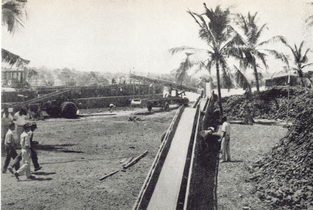
An die Stelle der primitiven Verlademethoden treten neuerdings in den Erzgruben von Goa moderne Förderbänder, die ein schnelleres Beladen der Schuten gestatten. Unser Bild zeigt eine Transporteinrichtung am Bandar Sircaín. Die in Deutschland gebaute und in Schwelgern erprobte Schute „Ferromo II“ liegt am Flußufer
