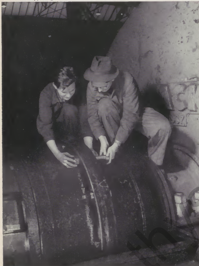
Unsere Mitarbeiter Vorarbeiter Willi Kempkens und Betriebsschlosser Fritz Hoff beim Auswechseln der Büchsen und Schrauben an einer schweren Walzwerkskuppelung
