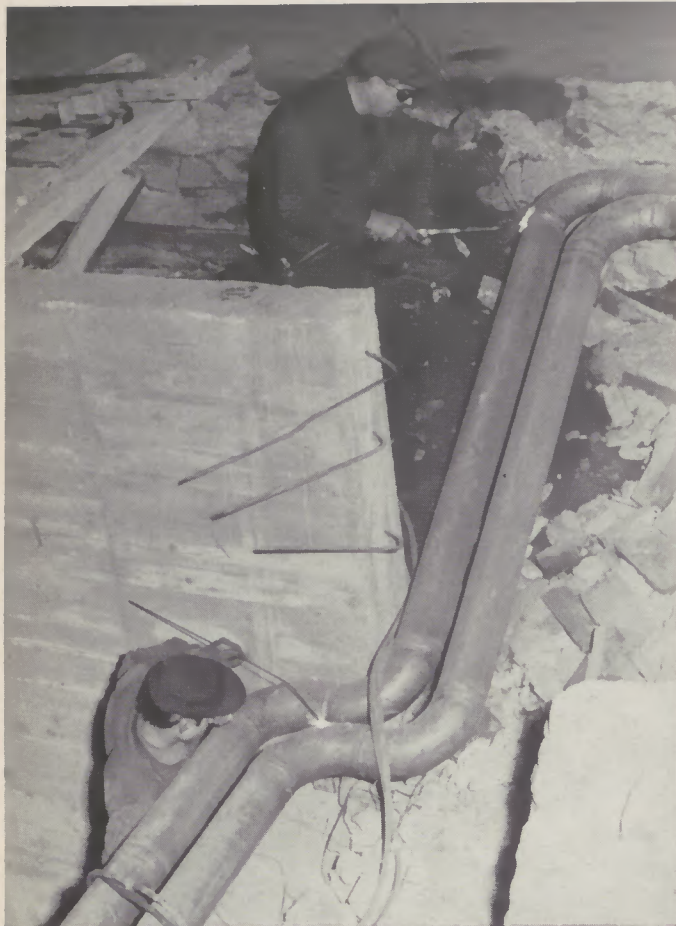
Unsere Mitarbeiter Rohrschlosser Ludwig Spatz und Willi Schmitt beim Schweißen von neuverlegten Kühlwasserleitungen in der Härterei
