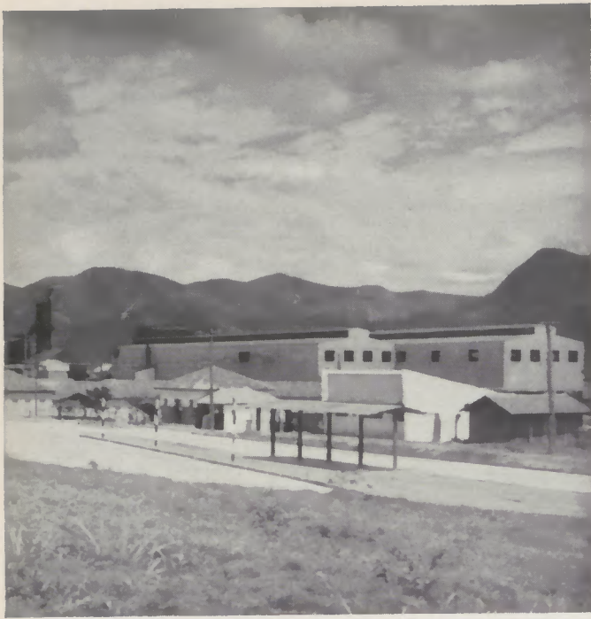
Werk Cia Acos Especiais Itabira mit Holzkohlenhochofen und Stahlwerk
