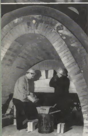
Rückseite: Unsere Mitarbeiter vom Baubetrieb, die Ofenmaurer Josef Reinartz und Heinrich Strömpkes beim Einbau eines neuen Türbogens an den auswechselbaren Segmenten der Blockstraßen-Ofen
