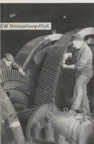
Titelbild: 2200 PS überträgt das Antriebsgetriebe der Blechstraße bei einem Unterstellungsverhältnis von 15:1. Wegen der dauernden stoßweisen Belastung müssen Lager und Zahnräder häufig kontrolliert werden. Unsere Mitarbeiter Johann Nelsen und Johann Hendrix bei der Prüfung nach einer Reparatur
