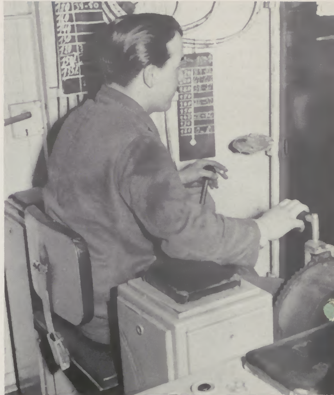
Auf der Steuerbühne der Blockstraße Steuermann Theodor Angenvoort steuert über eine elektronische Regelung die Geschwindigkeit des Walzenzugmotors
