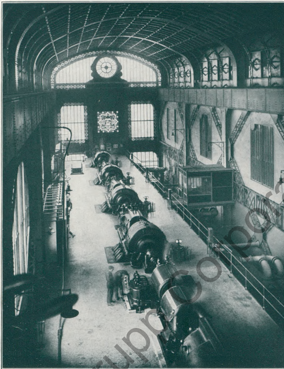
Blick in die Turbogebälsehalle der Druckluftzentrale.
