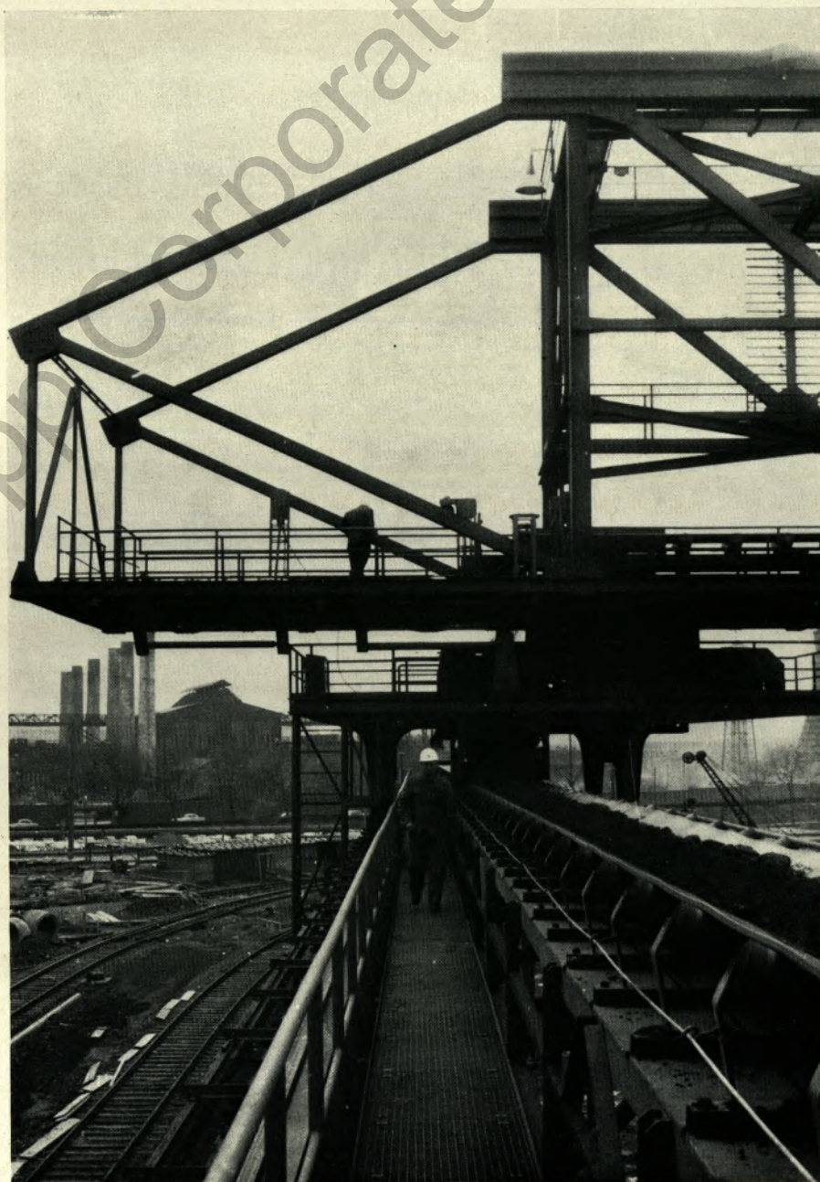
Die Übergabe von der Verladebrücke auf das Zubringerband der Erzbrech- und Siebanlage.
