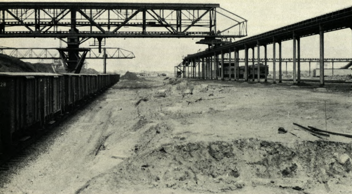
Das landseitige Ende der Verladebrücke II. Hier befindet sich die Übergabe auf das Förderband der ATH.
