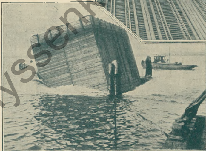
Besenken eines Caissons beim Bau der Brücke.
