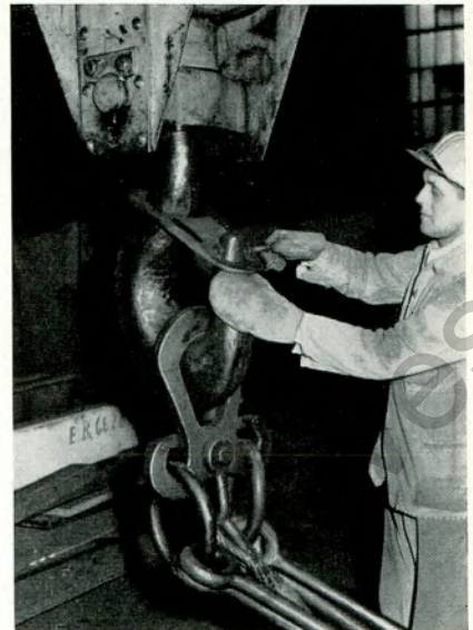
Auch der Doppelhaken ist gegen Herausfallen aus dem Kranhaken zu sichern
