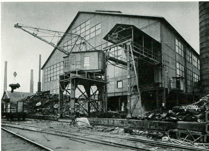
Hüttenanlage der Aktiengesellschaft mit Siemens-Martin-Ofen
