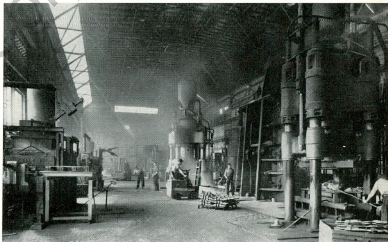
Große Schmiedehalle, erbaut 1935
