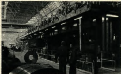
◀ Blick über den Behandlungsteil der neuen Anlage, in dem Stahlbänder mit Auflagen von Kupfer, Messing, Nickel oder Zink elektrolytisch veredelt werden
