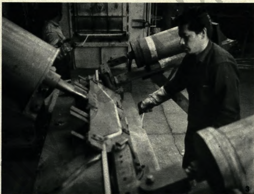
▼ Blick in den Betrieb: Torsions- stäbe werden angestaucht (1), auf einer 300-Tonnen-Presse werden Zugstreben geschmiedet (2), Stabilisatoren werden gebogen (3), im Labor wird das Material einer Härteprüfung unterzogen (4)
