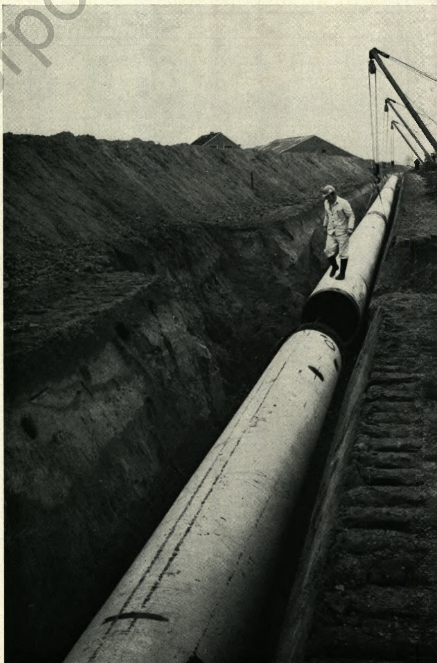
Verlegung von Rohren aus Novar-Stahl.
