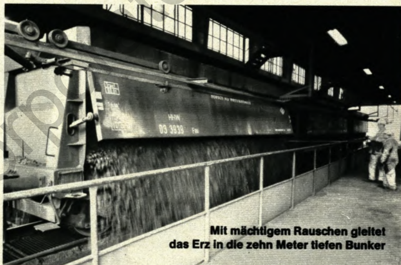
Die Halle über dem Erzumschlagbunker
