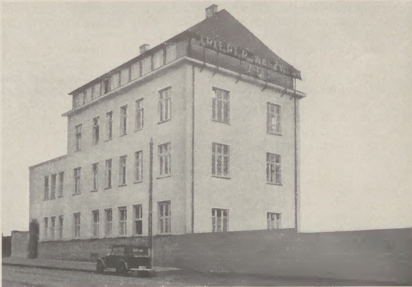
Verwaltungsgebäude in Wuppertal-Langerfeld
