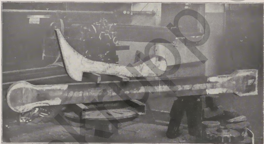
Abb. 93: Schubstange und Ranthebel, auf der „SU“-Maschine ausgechnitten
