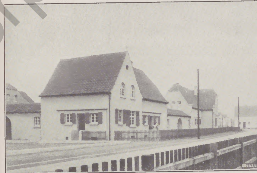
Hausgruppe in der Burgsdorfstraße während der Bauzeit
