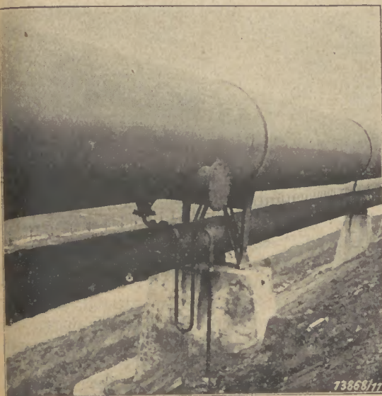
Bild 1: Anordnung von Einsteigöffnung und Entwässerung
