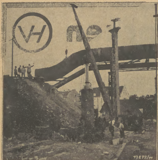
Bild 5: Anpassung eines 2000er Bogenstückes an die 700er Koks gasleitung
