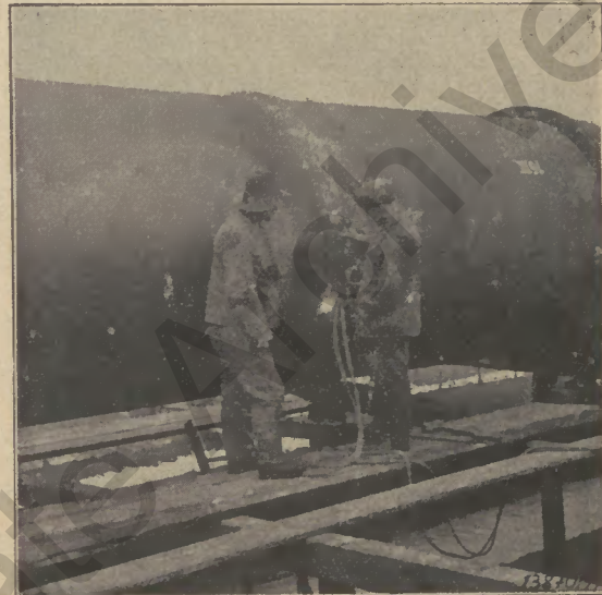
Bild 3: Muffenschweißung
