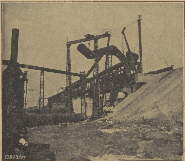
Bild 6: Einbau eines schwierigen Bogenstückes von über 20 Tonnen
