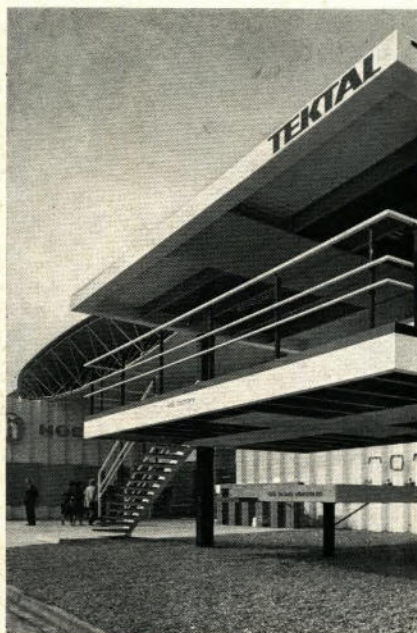
Titelseite: Viele Fragen und Gespräche kreisten bei der Hannover-Messe um das neuartige Hoesch-Dach TEKAL, das wir auf der Messe zum erstenmal der Öffentlichkeit vorstellten und dessen Bauelemente aus PLATAL, dem kunststoffbeschichteten Stahlblech, bestehen
