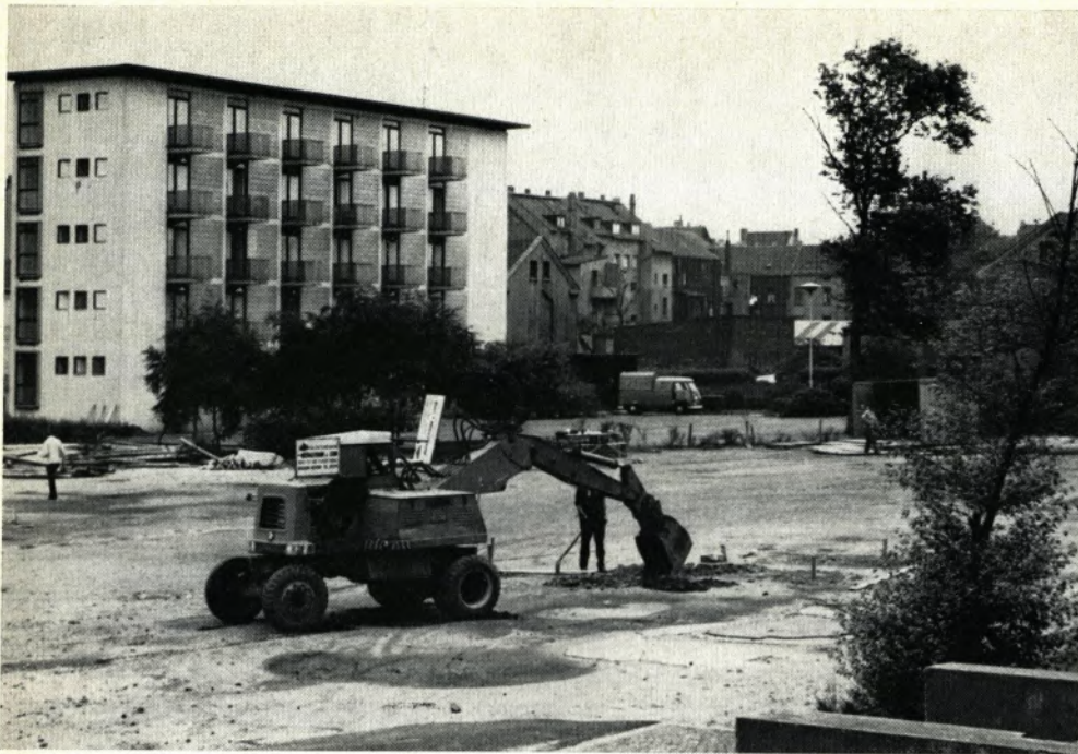
Der Bagger grub den ersten Hub in die Erde
