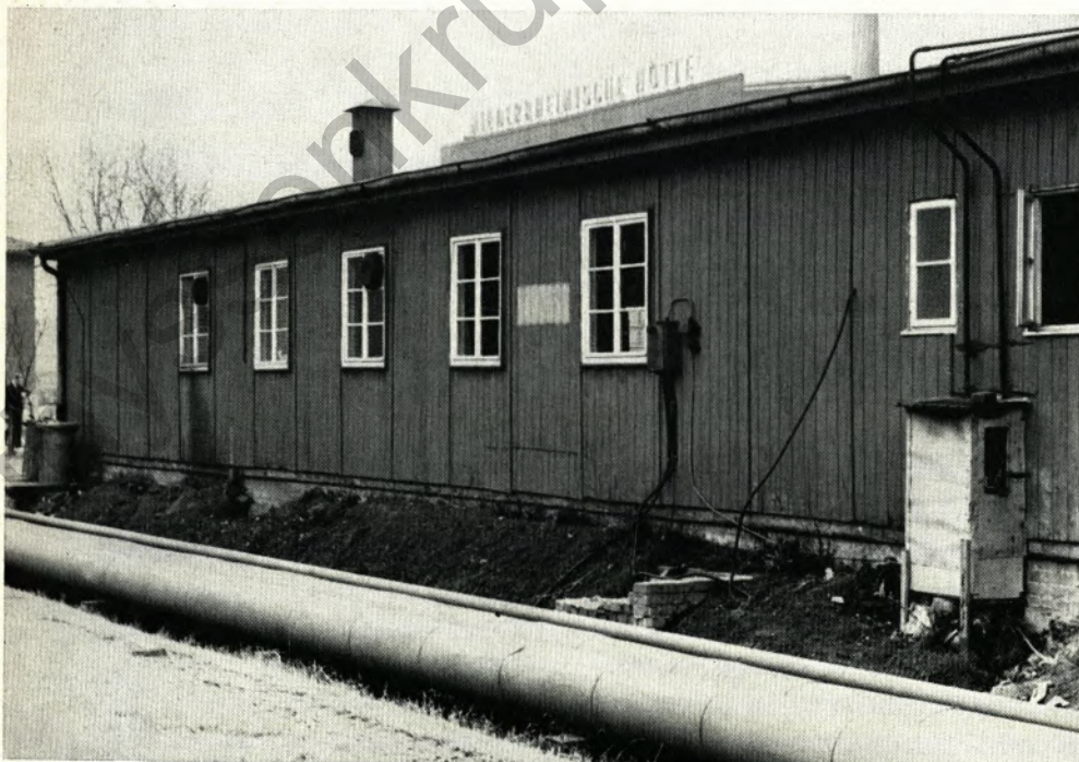
Bald wird das ein Speisesaal gewesen sein
