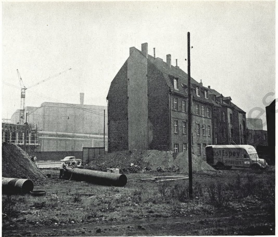
Diese Häuser an der Kaiser-Wilhelm-Straße wurden im November geräumt und sind inzwischen den Vorbereitungen zum Bau des neuen Verwaltungsgebäudes gewichen
