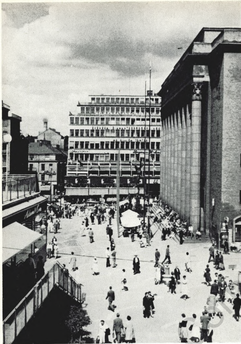
Die Bilder dieser Seite zeigen zwei bemerkenswerte Ansichten der schwedischen Hauptstadt Stockholm mit dem Konzerthaus (oben) und modernen Wohn-Hochhäusern (unten) in unmittelbarer Nähe des Wassers. Im Vordergrund eine große Straßenbrücke für den starken Autoverkehr
