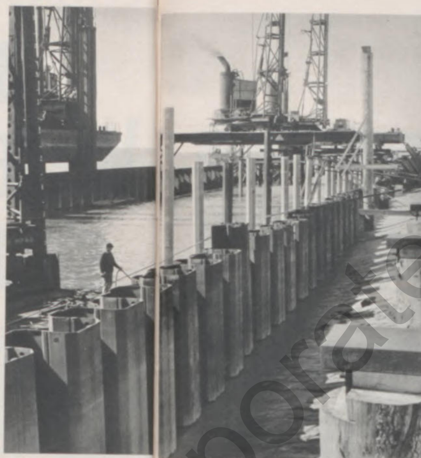
◀ Blick auf die beiden Stahlspundwände, die das Kajenbauwerk zur See und zum Landabschließen; die Spundbohlen sind bis zu 32,70 Meter lang
