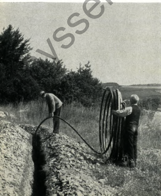
Wie ein Kabel wird dieses Kunststoffrohr aus Polyäthyl für eine Wasserleitung im Raum von Paderborn verlegt
