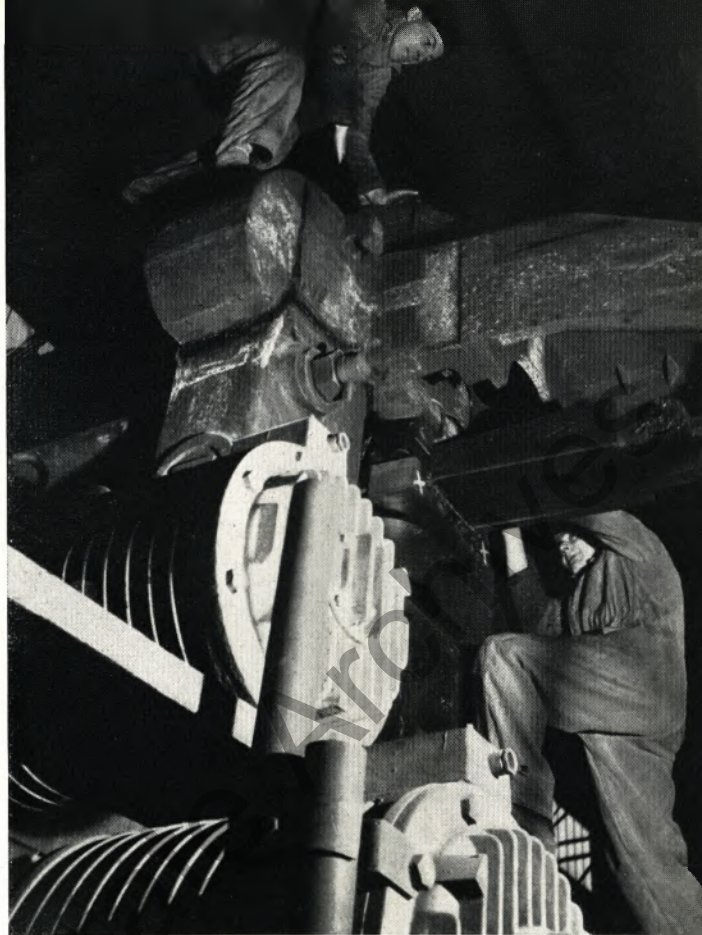
Reparaturen dürfen den Betriebsablauf nicht stören. Daher müssen sie in Arbeitspausen durchgeführt werden, wie hier die Arbeiten am Walzgerüst
