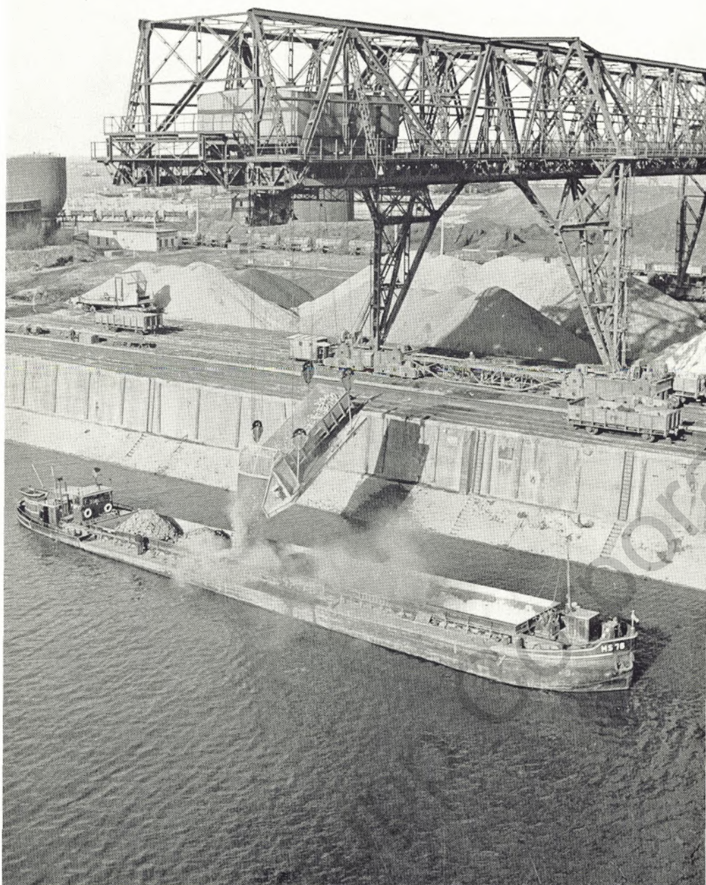
UNERMÜDLICH SIND IM WERKSHAFEN SCHWELGERN Kranbrücken und Portalkräne tätig. Tag und Nacht geht hier der Betrieb. Um den wachsenden Umschlagverkehr bewältigen zu können, wird der Stichhafen vergrößert und mit neuen Entlade-Anlagen ausgestattet (Siehe hierzu auch den Bericht auf den Seiten 11 bis 13 in der Mitte des Heftes) Unser Bild zeigt die Waggonentladebrücke am Gegenufer des Stichhafens
