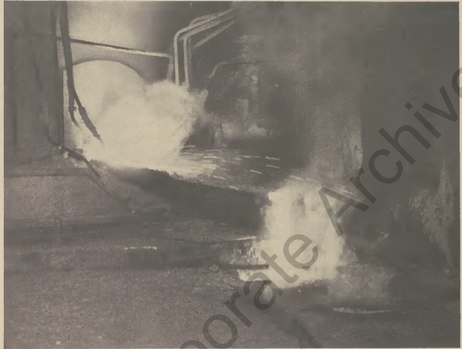
Schlackenabstich am Hochofen I in Niederschelden
