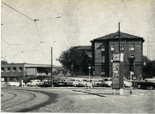
Die alten Häuser vor dem Tor 1 a in Ruhrort sind abgerissen worden. Der freigewordene Platz kann vorerst als Behelfsparkplatz genutzt werden.
