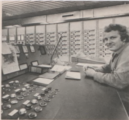
◀ Nur drei Mitarbeiter je Schicht sind in der Lage, die Haubenglüherei zu betreiben. Voraussetzung dafür sind die in der zentralen Meß-, Kontroll- und Regelorgane – hier überwacht von Rudolf Niehaus
