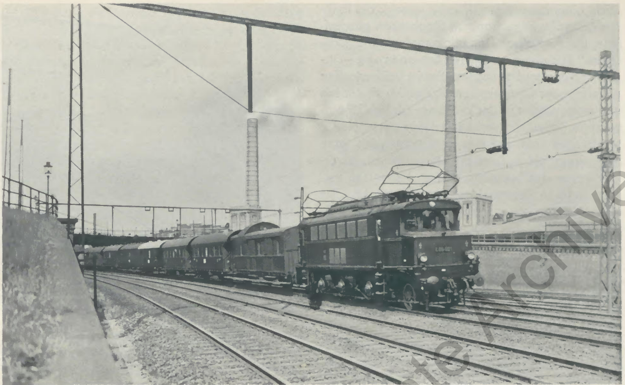
Elektrische 1Co1-Schnellzug-Lokomotive Reihe E05 der Deutschen Reichsbahn Vergl. S. 73 mit Eilzug Magdeburg-Leipzig
