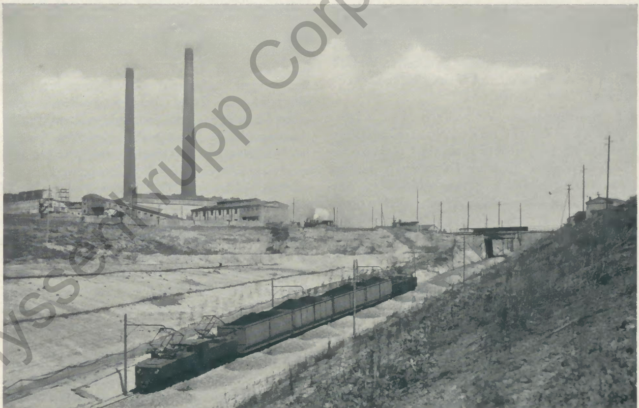
Schwere elektrische Abraum-Lokomotiven im Betrieb der Grube Regis-Breitingen Vergl. S. 76 der Deutschen Erdöl-AG
