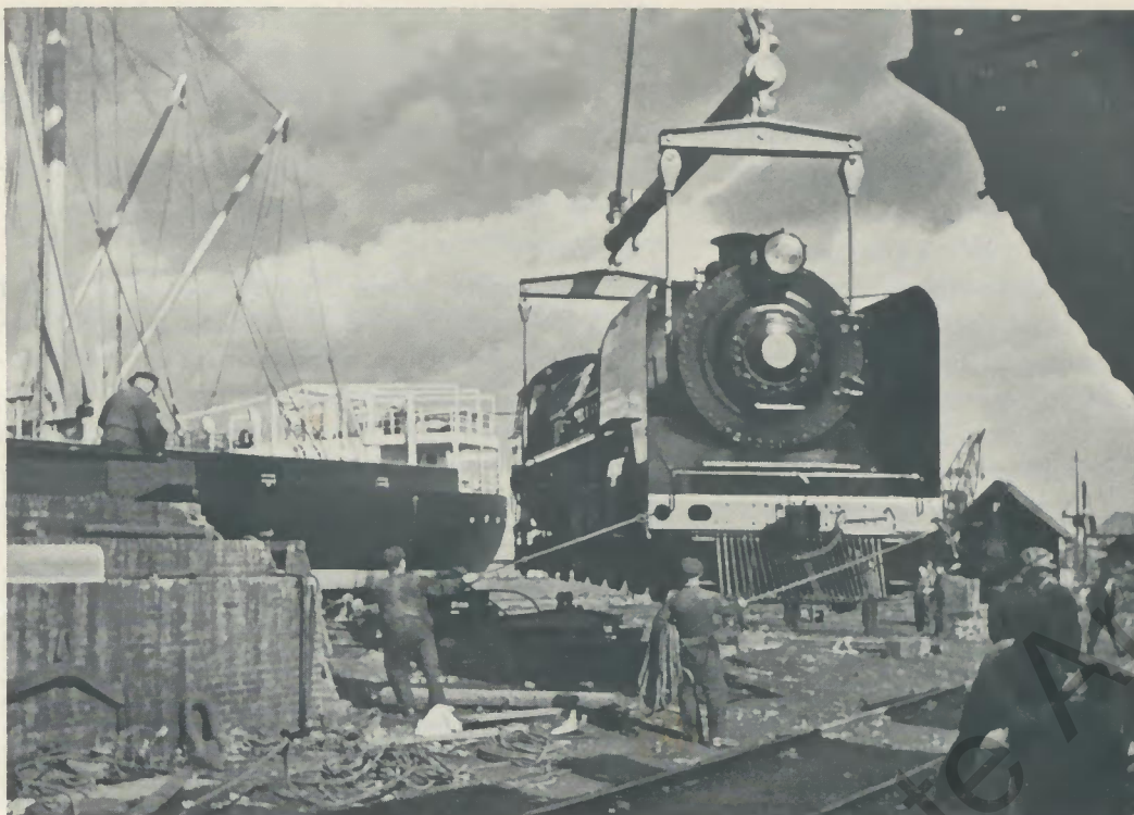
Verladen der 2D2- Schnellzug- Lokomotiven für Chile in Bremerhaven
