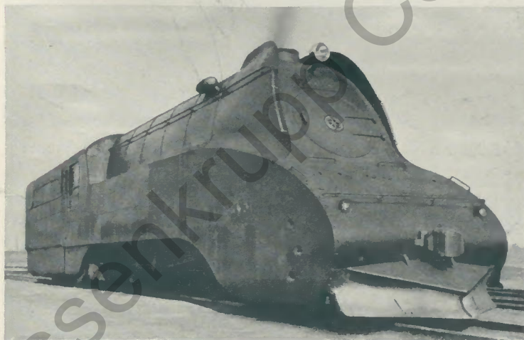
1934 Stromlinienzug der Japanischen Staatsbahnen mit umgebauter 2C1-Lokomotive der Regelbauart, 1067 mm Spur
