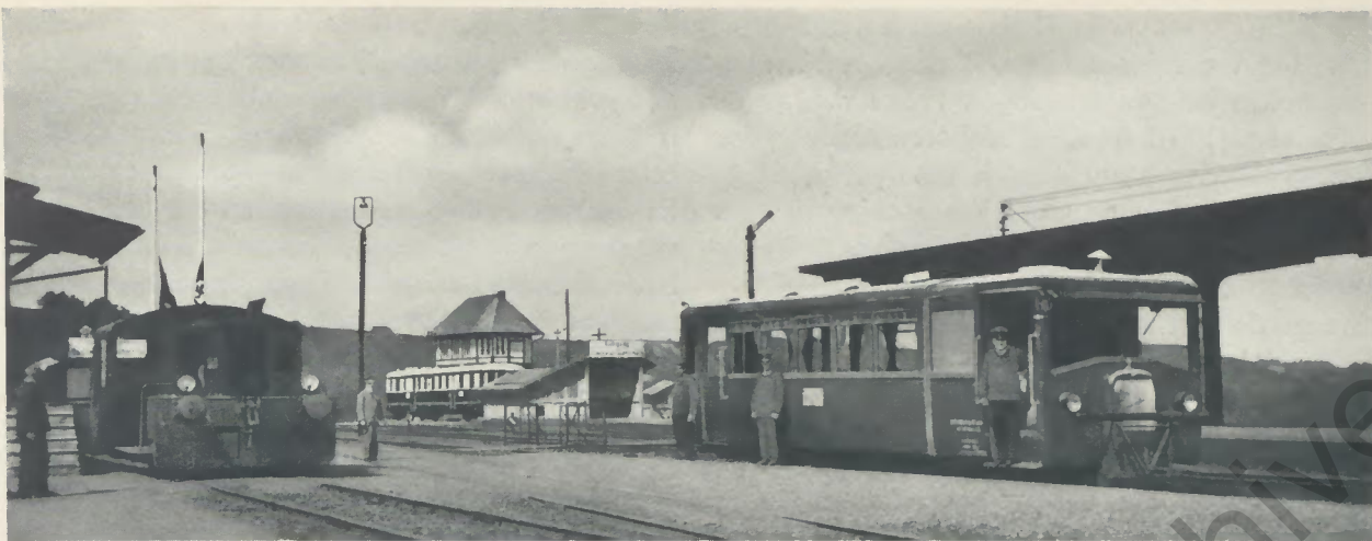
Diesel-elektrische Henschel-Verschiebe-Kleinlokomotive, Henschel-Dampf-Triebwagen der Deutschen Reichsbahn und Henschel-Schienen-Omnibus der Kleinbahn Grifte-Gudensberg auf Bahnhof Grifte
