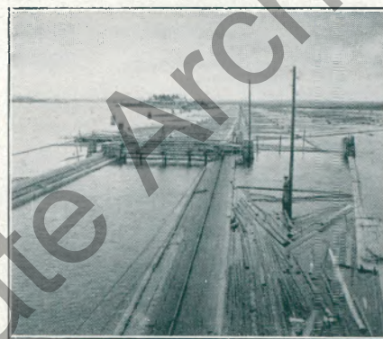
Eine moderne Flößholzsortieranlage am Auslauf des Kalix-älv in Nordschweden. Blick auf eine der seitlichen Flößgassen. Im Vordergrund das „bundverk“.
