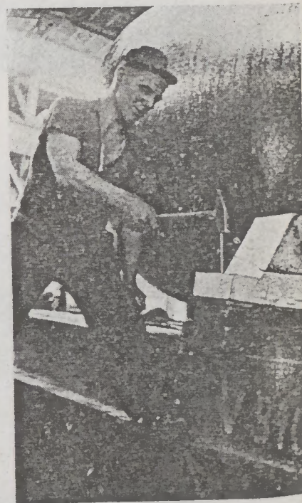
Auf dem Tiefladewagen entsteht mit viel Holz und noch mehr Nägeln ein festes Bett
