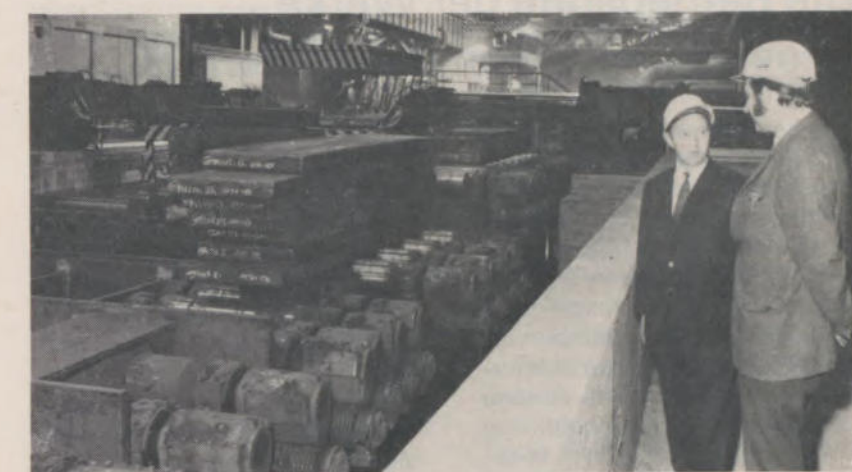
< Blick in das neu errichtete Vorbrammenlager Halle O. Im Vordergrund ein Teil des Brammenpaketförderers mit einem Brammenstapel auf dem Übergabewagen.
