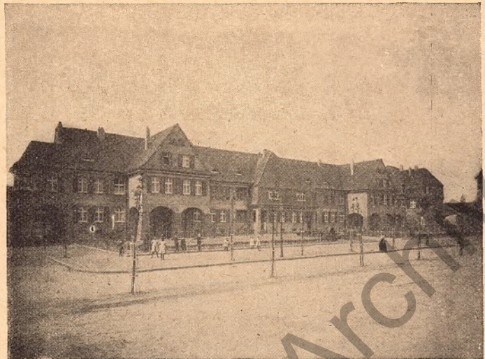
Abb. 8. Reihenwohnhaus für Angestellte der Schachtanlage Alma in Gelsenkirchen, Hohensriedberger Straße
