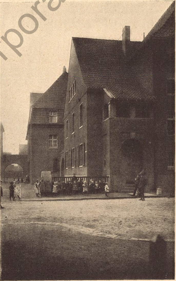
Abb. 23. Arbeitersiedlung der Zeche Westhausen in Bodelschwingh bei Dortmund
