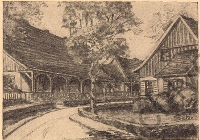
Abb. 20. Arbeiter-Siedlung der Zeche ver. Minister Stein und Hardenberg in Dortmund-Eving — Siedlung „Exterberg-Ost“, Forsthausstraße
