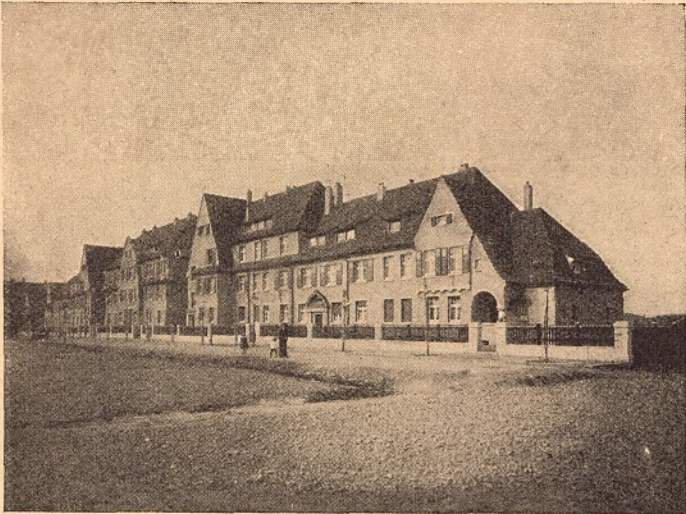
Abb. 7. Beamtenwohnhäuser der Schachtanlage Alma in Gelsenkirchen, Torgauer Straße
