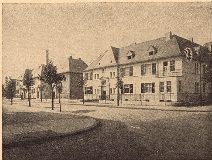
Abb. 5. Arbeitersiedlung „Ecke Süd- u. Knappschaftsstraße“ in Gelsenkirchen, Häuser an der Knappschaftsstraße
