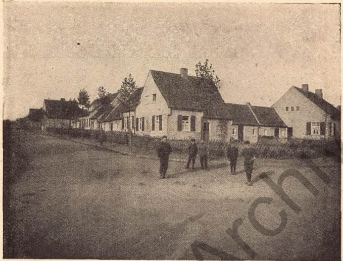
Abb. 31. Arbeiterfiedlung „Schönhausen“ der Schachtanlage Grimberg in Bergkamen
