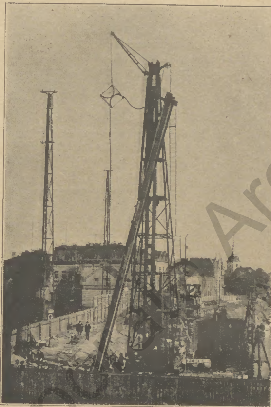
Das Hochziehen des Spundwandisens am Rammergerüst.
