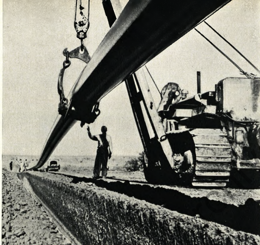
Wo Erdöl gefördert wird, werden Rohre benötigt. Gerade in den Staaten des vorderen Orients durchziehen unzählige Pipelines die Erde. Hier die Verlegung von Rohren für eine Ölleitung
