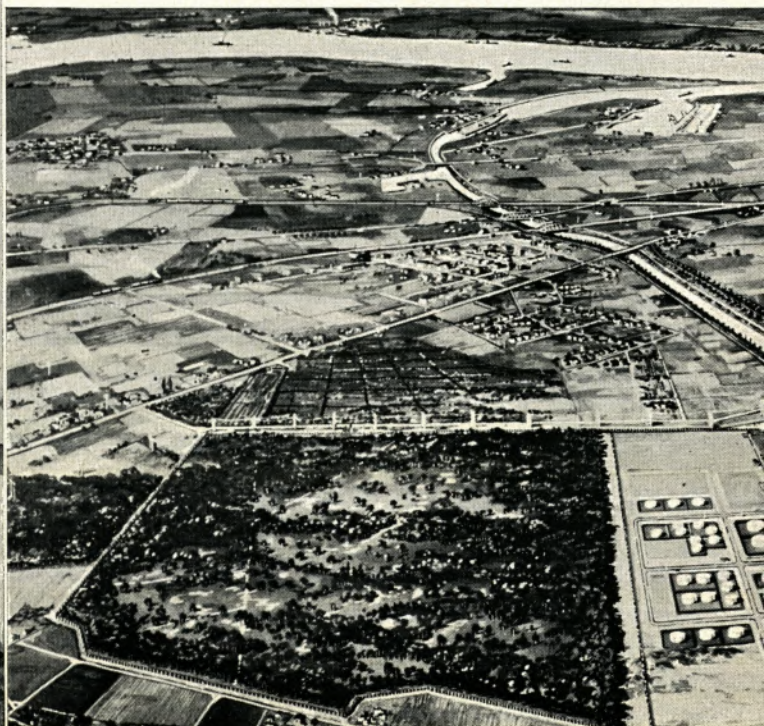
Eine Fotomontage von der neuen BP-Raffinerie in Bucholtzweilmen (Kreis Dinslaken), die am 20. Oktober in Betrieb genommen wurde. Im Vordergrund erkennt man die Werksanlagen. Das helle Band im Hintergrund ist der Rhein.
