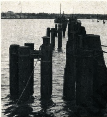
RHEINROHR-Dalben am Nord-Ostsee-Kanal
