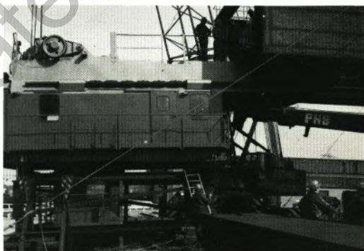
Hier erfolgt das Einheben der Greiferkatze.
