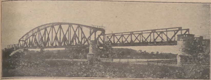
Eisenbahnbrücke über die Weser bei Nienburg. Halbparabelträger mit Zwischensystem.
