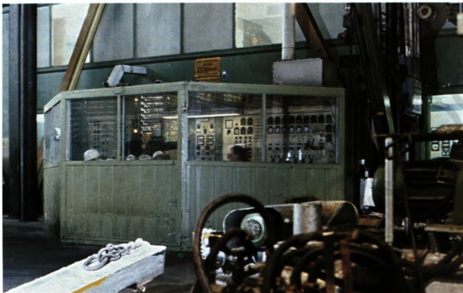
Ein Beispiel für Lärmschutz im Betrieb: Der Steuerstand an der Bandverzinkung in Beeckerwerth ist von einer stark schallisolierenden Kabine umgeben (siehe dazu auch Interview Dr. Zimmermann).
