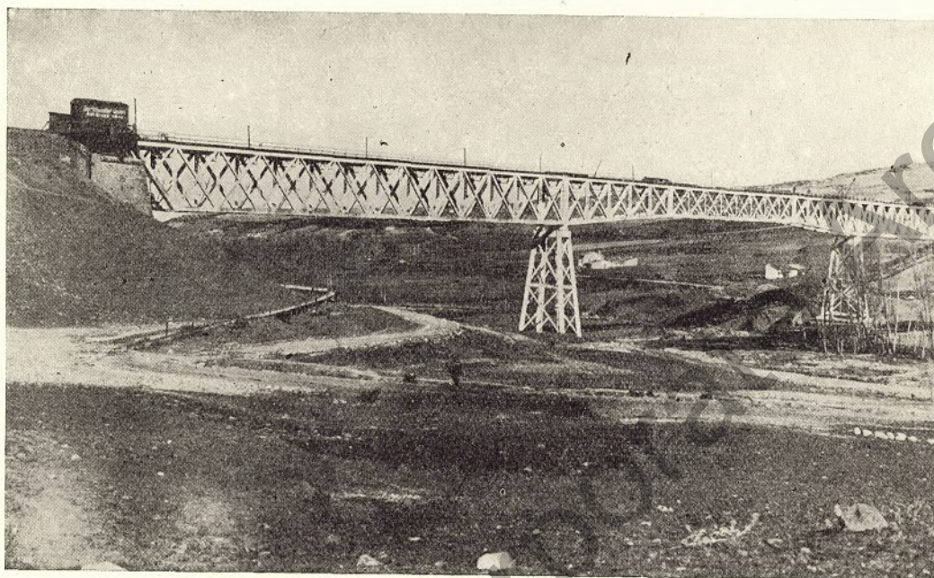
Abb. 1. 26. Januar 1923 — Die Eisenbahnbrücke bei Gor in der alten Lage
