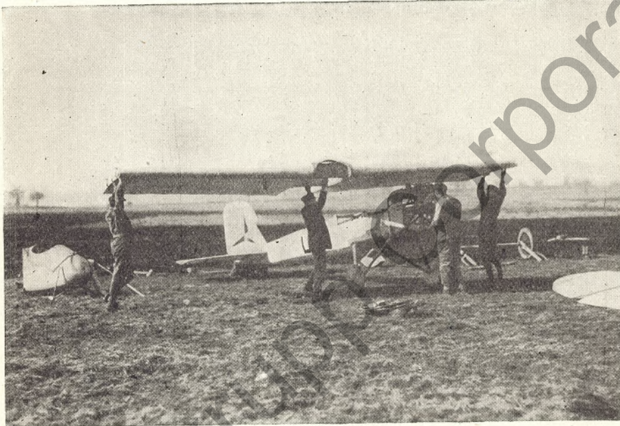
Abb. 2. Das völlig zerlegbare Flugzeug wird aufgebaut
