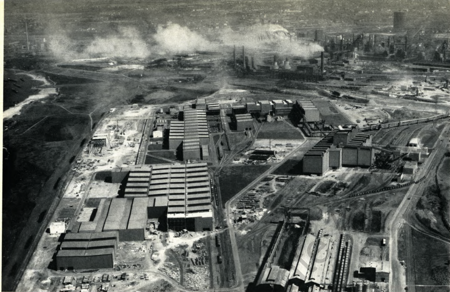
Luftaufnahme der neuen Betriebe der August Thyssen-Hütte in Duisburg-Beeckerwerth. In der Mitte rechts das Oxygen-Stahlwerk, darüber die Hallen der Tiefofen-Anlage und der Universal-Brammenstraße, oben links der Warmbreitbandstraße. Vorn links liegt das Kaltwalzwerk. Deutlich erkennbar sind auch die Hallengebäude der Belegschaftshäuser. Unmittelbar am Deich befindet sich die neue Verzinkungsanlage 2 noch im Bau. Vorn rechts erstrecken sich die Anlagen der Thomas-schlackenmühle und der Zementfabrik der August Thyssen-Hütte.
