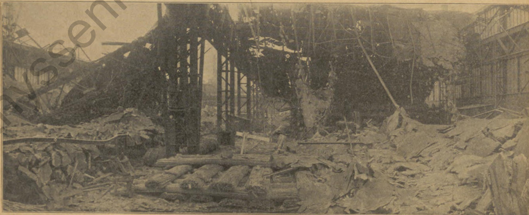
Links Feinstraße, rechts Schnellstraße, mit dem einzigen nicht heruntergestürzten Kran, über dem ein Teil der Betondecke hängt.
