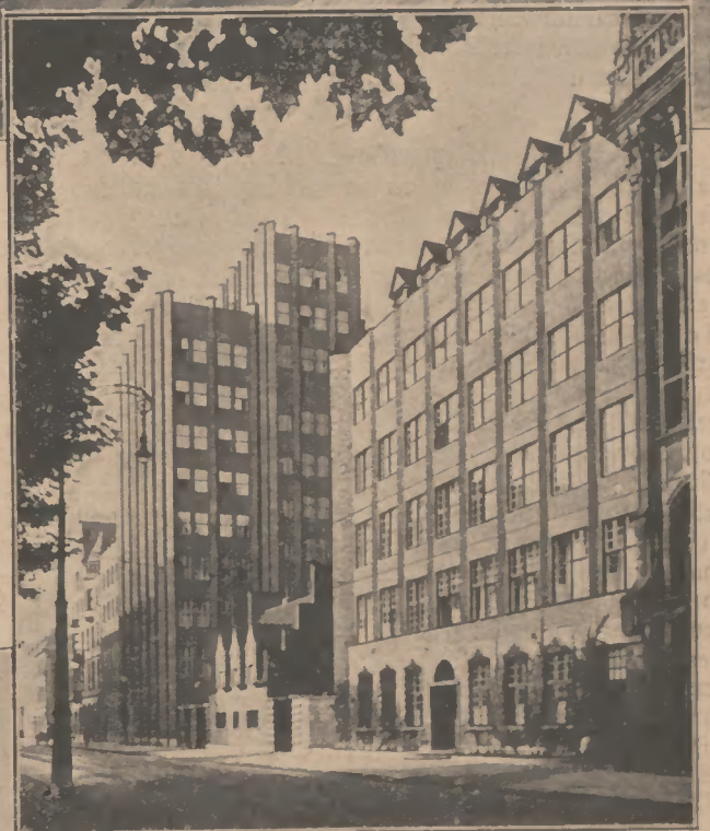
Hauptverwaltungsgebäude in Düsseldorf.
