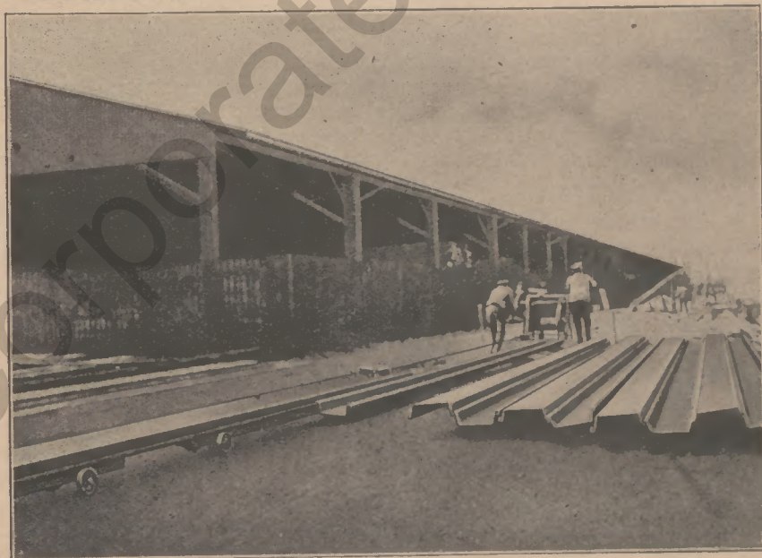
Abb. 3: Zusammensetzen zweier Larsseneisen.
