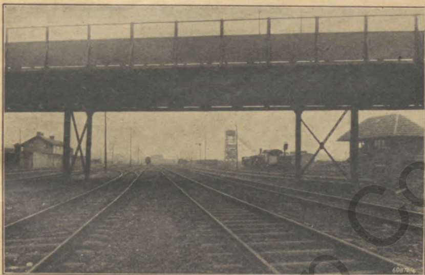
Abbildung 5: Elektrisches Stellwerk (rechts)
