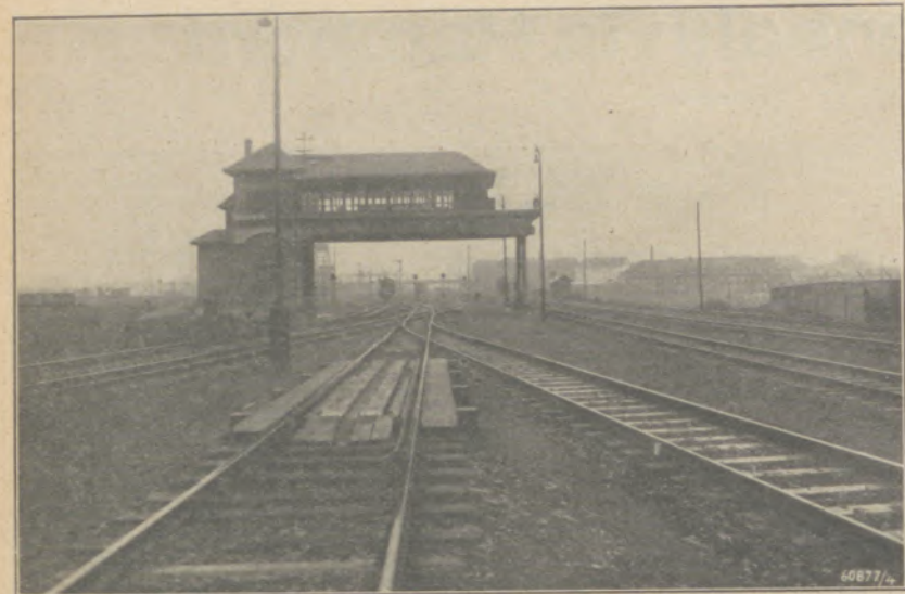
Abbildung 6: Stellwerk im Vorbahnhof. Im Vordergrund Gleisbremse „Bauart Thyssen“
