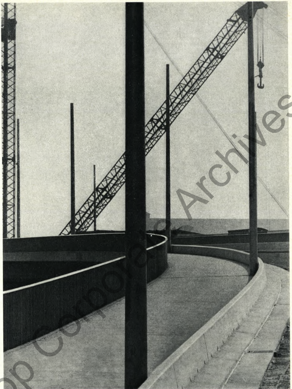
Oben: Einige der 99 Lichtmasten, die unsere Tochter „Stahlform Berlin“ für die Abfahrten der Kniebrücke lieferte. Unten ein Blick auf die Brücke mit den rechtsrheinischen Abfahrten.
