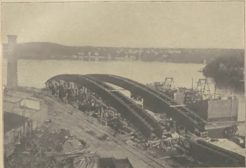
Abb. 6: Zusammengebaute Bögen auf der Ekensbergswerft in Stockholm
