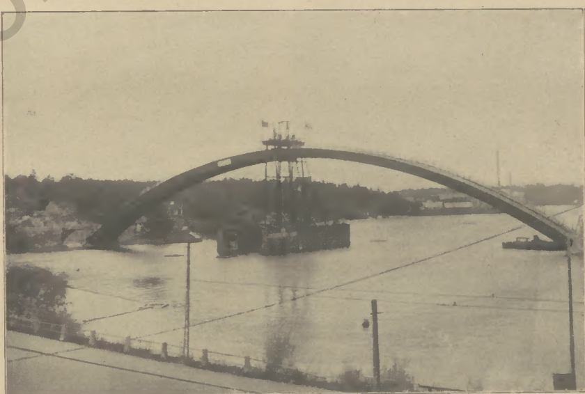
Abb. 9: Zusammenschluß der Bogenhälften
