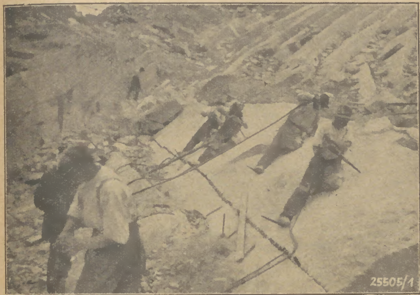
Mit Preßluftbohrern bei der Sprengarbeit im Steinbruch
