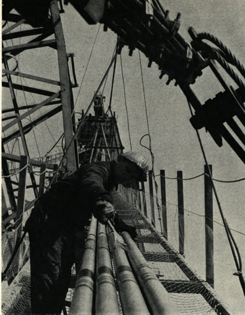
Mit Hochdruck wurde an der Severinsbrücke gearbeitet. Der Verkehrsstrom trieb dazu an
