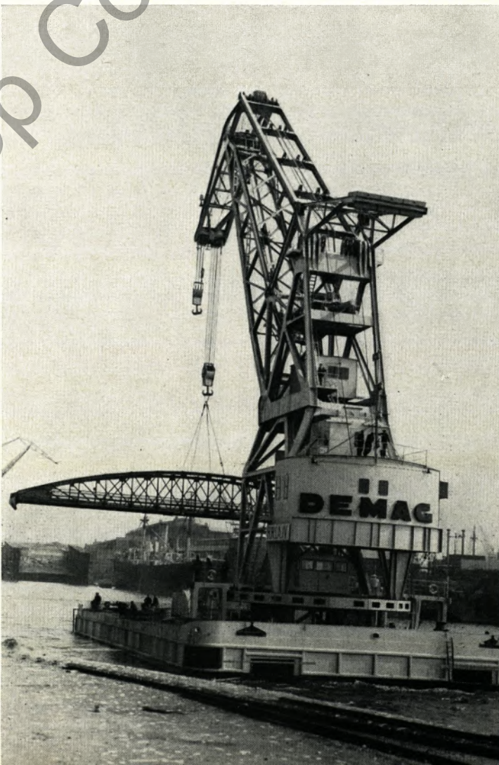
Ein 200-t-Schwimmkran wurde für den Hamburger Hafen mit unseren Blechen von Blohm & Voss und der DEMAG gebaut
