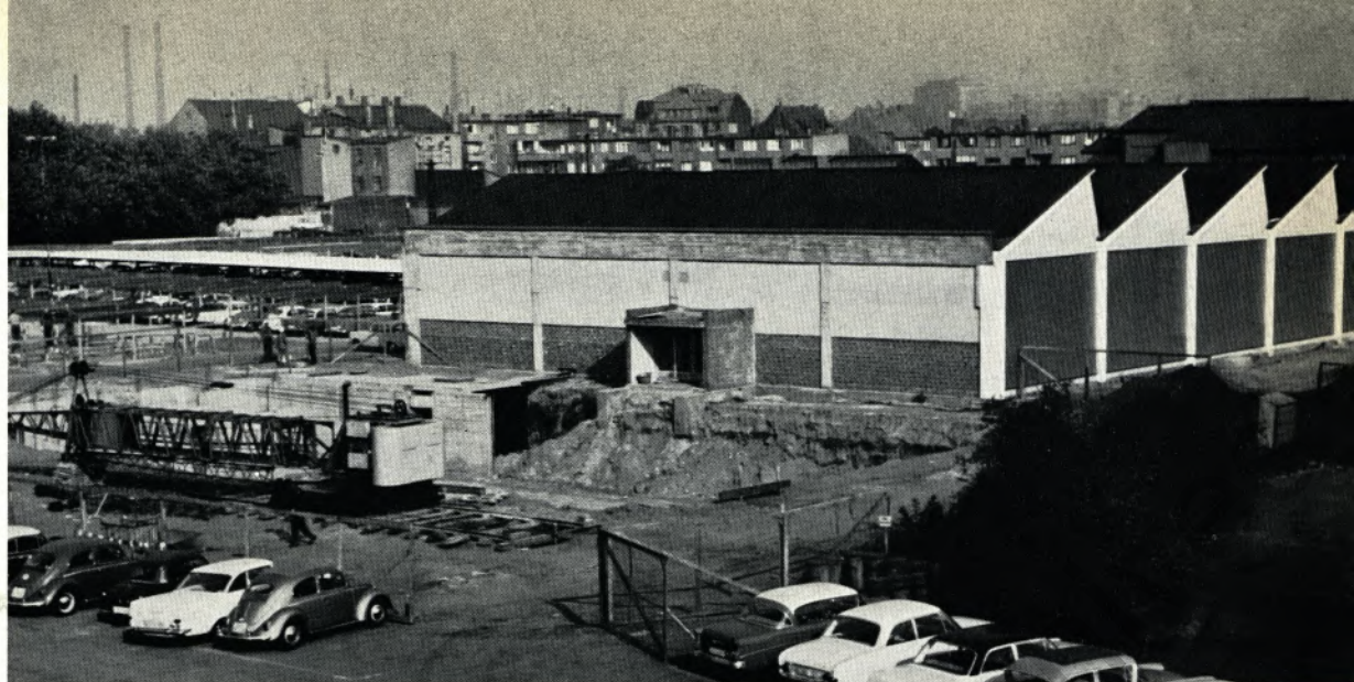
Blick vom Hauptverwaltungsgebäude der Niederrheinischen Hütte auf die neuerbaute Lehrwerkstatt. Auf diesem Bild ist an der Halle der außen liegende Sonnenschutz heruntergelassen. Im Vordergrund erkennt man den Beginn der Arbeiten für den 2. Bauabschnitt des ohne Unterbrechung erstehenden Ausbildungszentrums.
