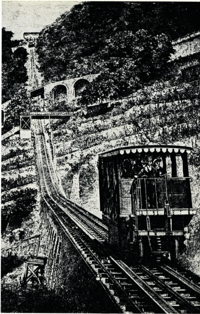
Als steilste Bergbahn ihrer Zeit — mit Steigung bis zu 57 Prozent — baute der schweizerische Ingenieur Riggenbach 1883 die Drahtseil-Zahnradbahn von Montreux-Territet nach Gllion. Ihre Wagen fuhren mit Wasser, ohne es erst — wie die Lokomotiven — in Dampf verwandeln zu müssen: Der talwärts fahrende Wagen füllte in Gllion seinen Wassertank, der in Territet wieder entleert wurde, und zog mit seinem Übergewicht den bergwärts fahrenden zur Höhe.
