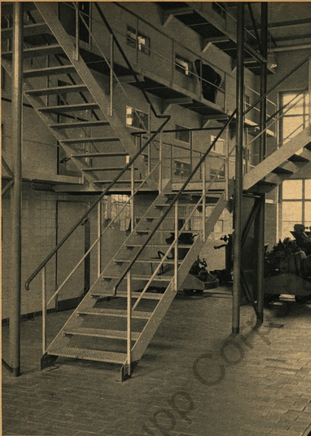
Ein Blick in die Halle des Grubenrettungshauses der Altenessener Bergwerks-AG. Links ist zu erkennen, daß die Versuchsstrecken in sechs Sohlen übereinander angeordnet sind
