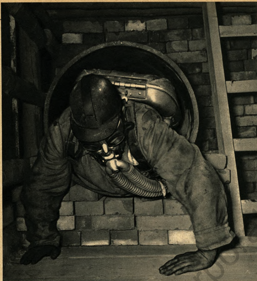
Nur sechzig Zentimeter Durchmesser hat das Dammrohr, durch das Heinz Regelman kriecht
