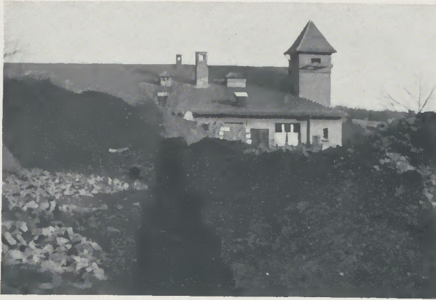
Die Wasserleitung wird gelegt Im Hintergrund die Henschel-Geflügelfarm
