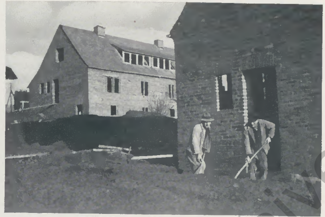
Der Bauschutt wird entfernt Der Bau geht seiner Vollendung entgegen
