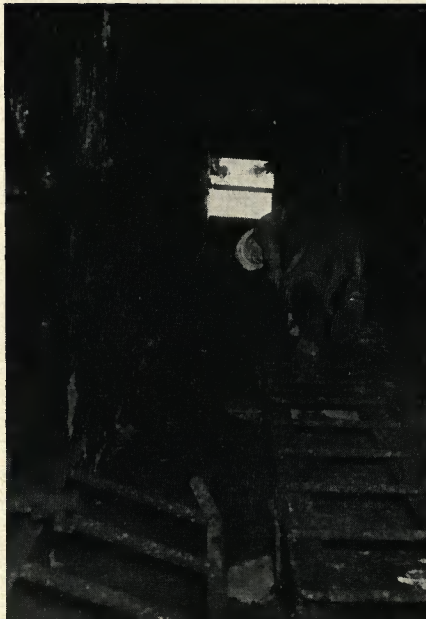
Wenn jemand, wie auf dem linken Foto, in die „Unterwelt“ einsteigt, ist er mehrfach gesichert. Seine Kollegen halten ihn am Seil (rechts), während er im Schacht arbeitet, um ihn notfalls herauszuziehen.
