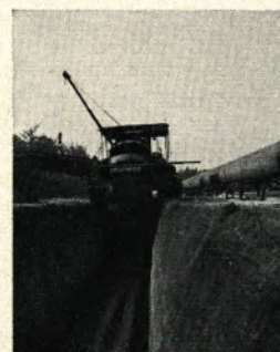
Die Pipelines aus unseren Rohren für die Fortleitung der großen Erdgasfunde in Holland werden jetzt verlegt. S. 12/13
