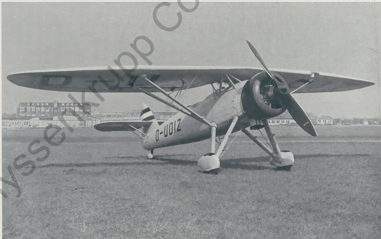
Henschel-Übungs- und Mehrzweckflugzeug mit Siemens-SAM-22-B-Motor
