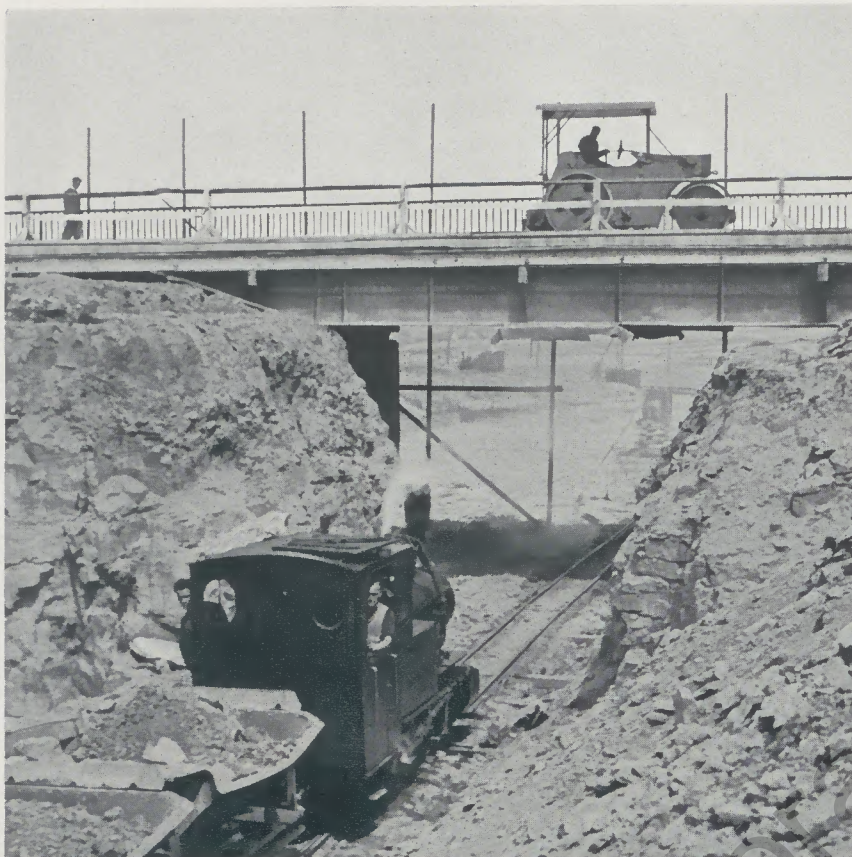
Zwei „Arbeitskameraden“ von H. & S., eine Henschel-Bau-Lokomotive und eine Motor-Straßen-Walze begegnen sich beim Bau der Reichsautostraße
