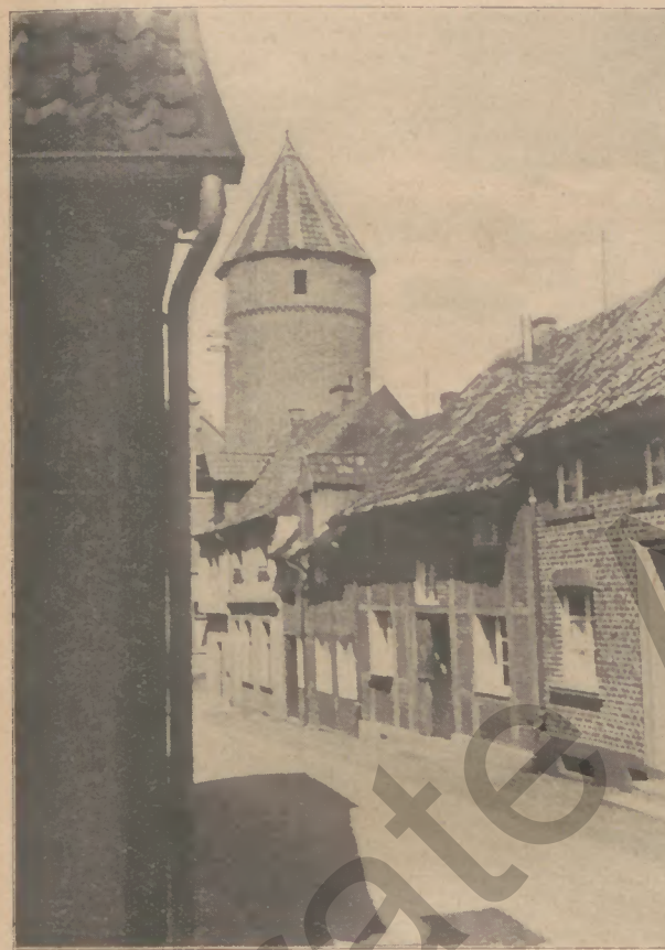
Dülmen (Westfalen): Stadtmauerturm
