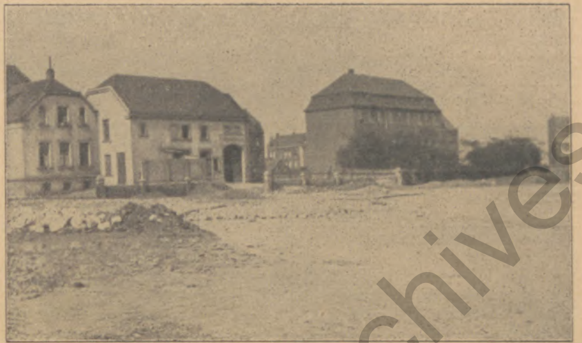
Die noch im Bau befindliche, rund um den Platz führende große Laufbahn.
