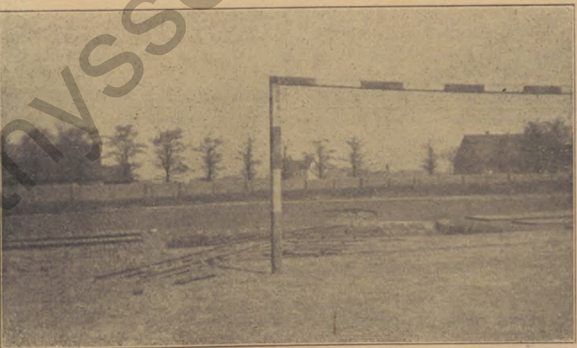
Die Sprunganlagen an der Westseite des Platzes.
