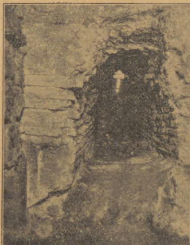
Syrischer Wasser- und Salzraum mit Feuerungsanlage.
