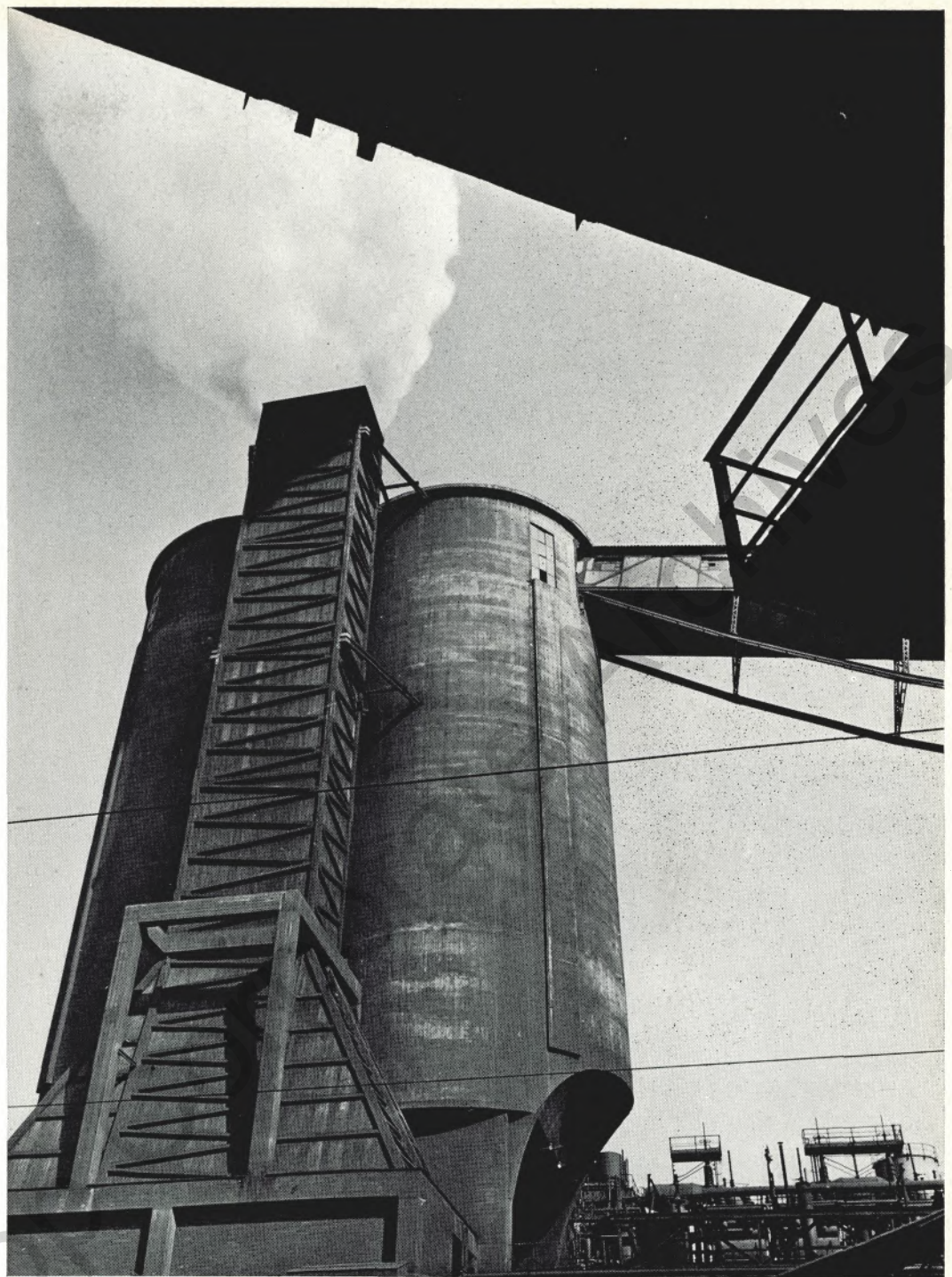
Der neue Kohlenturm unserer Kokerei August Thyssen in Hamborn wurde in Spannbeton mit Hüttenzement unserer eigenen Zementfabrik errichtet — ein Beweis für die hohe Qualität des ATH-Zements
