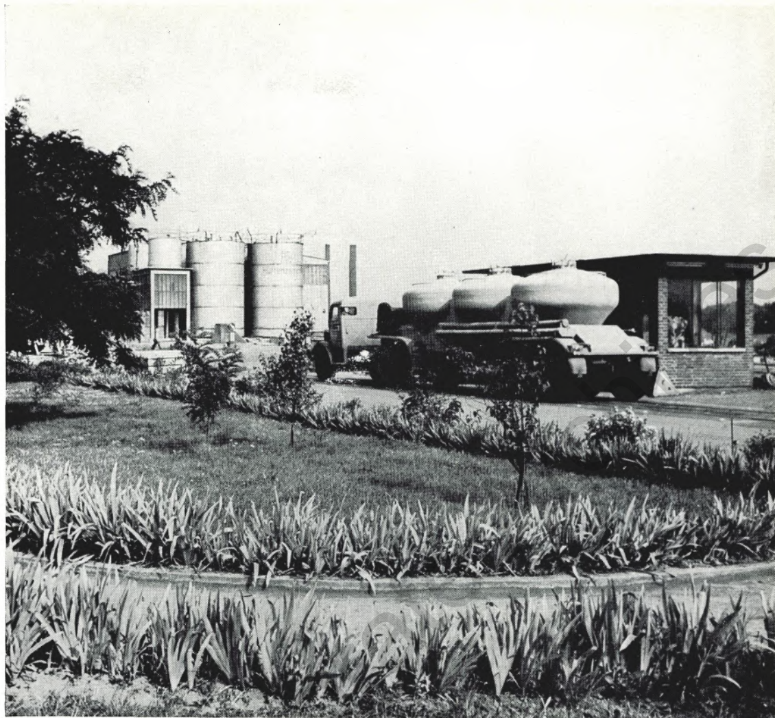
Ein alltägliches Bild in der neuen Zementfabrik unserer Hütte in Beeckerwerth: Ein ausländischer Tank-Lastwagen fährt über die Waage, um in der Silo-Anlage Zement für seine Baustelle zu laden
