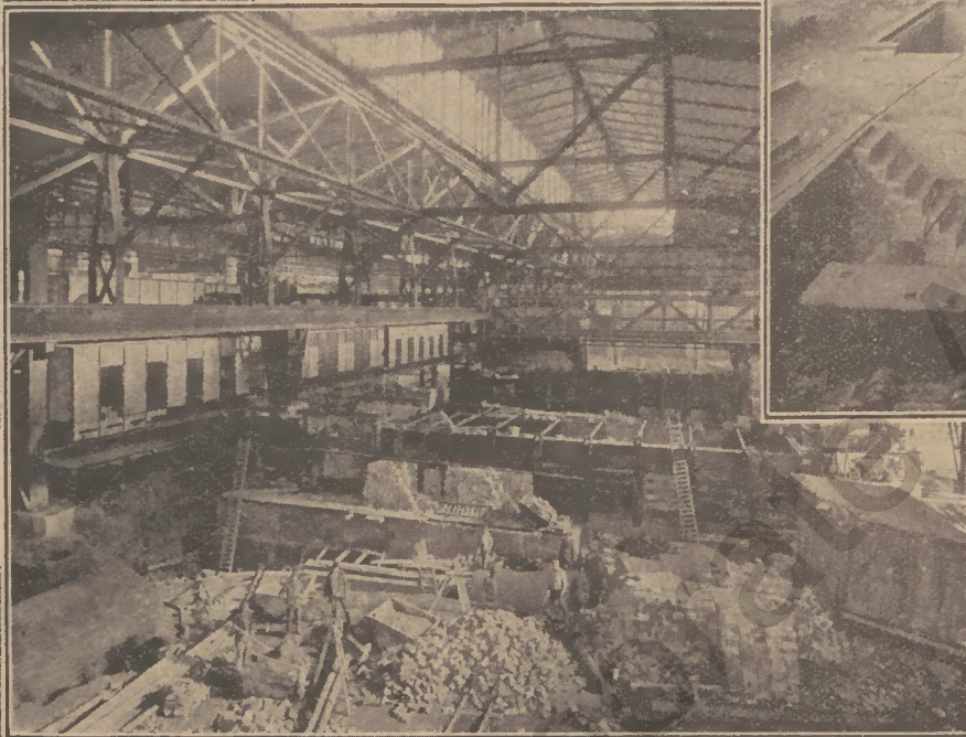
Abb. 13: Blick in die Baugrube für den Rauchkanal und auf den neuen Kamin. (18. 2. 26.)
