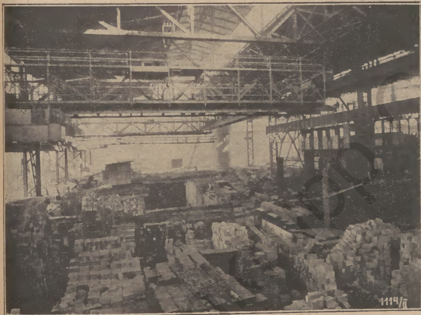
Abb. 10: Halle I. Bau der Ofenanlage. Blick auf Stoföfen I vom Hauptweg aus gesehen. (12. 1. 26.)
