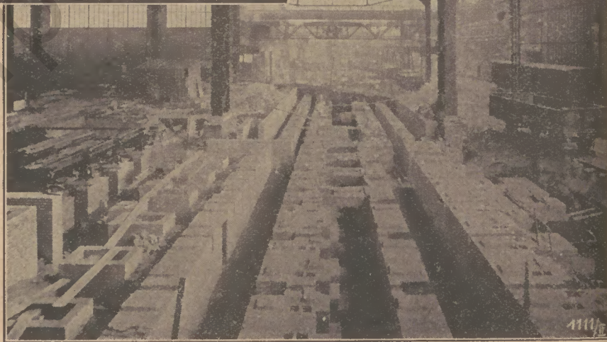
Abb. 17: Fundament hinter der Straße nahezu fertig. (25. 9. 26.)
